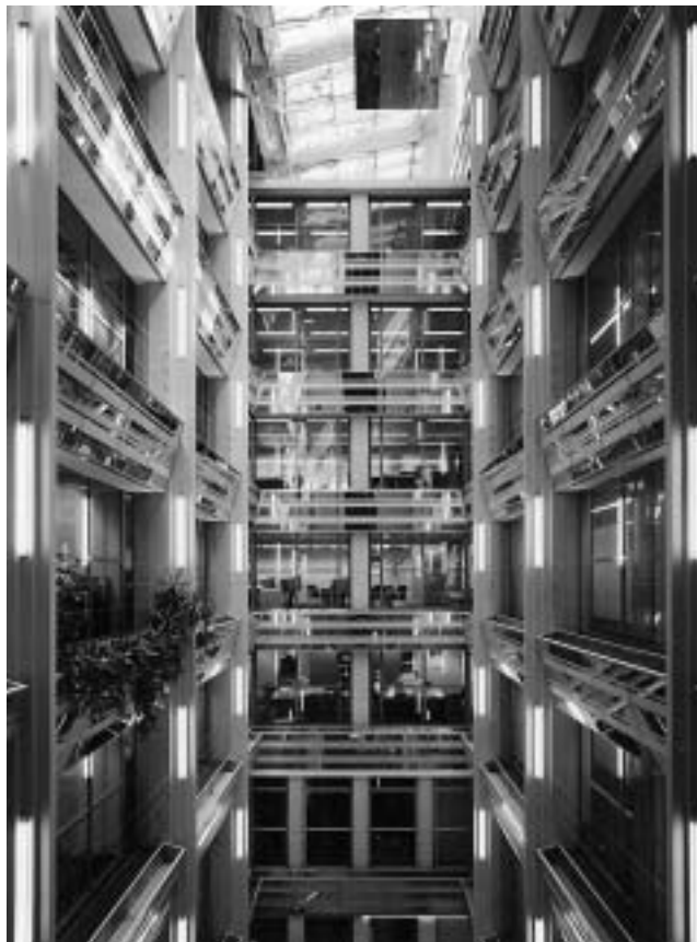
FOTO 2: SPIEGEL IN CENTRALE HAL BANK MEES PIERSON ROTTERDAM OM DAGLICHT VANAF EEN DAK NAAR BENEDEN TE REFLECTEREN FOTO PETER DE RUIG, DEN HAAG
