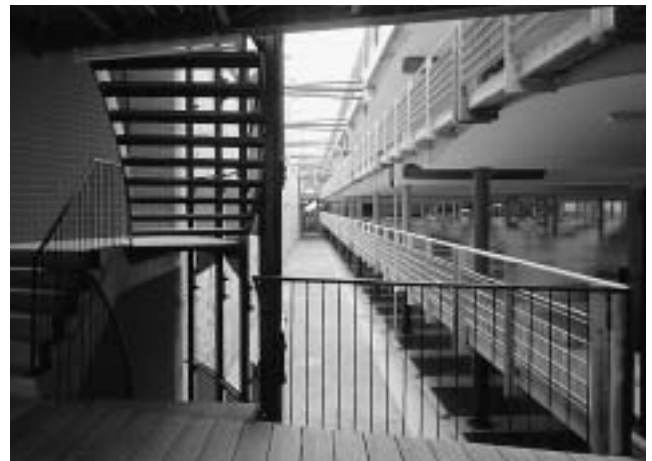
FOTO 1: ONDERGRONDSE PARKEERGARAGE UMC ST RADBOUD NIJMEGEN.
